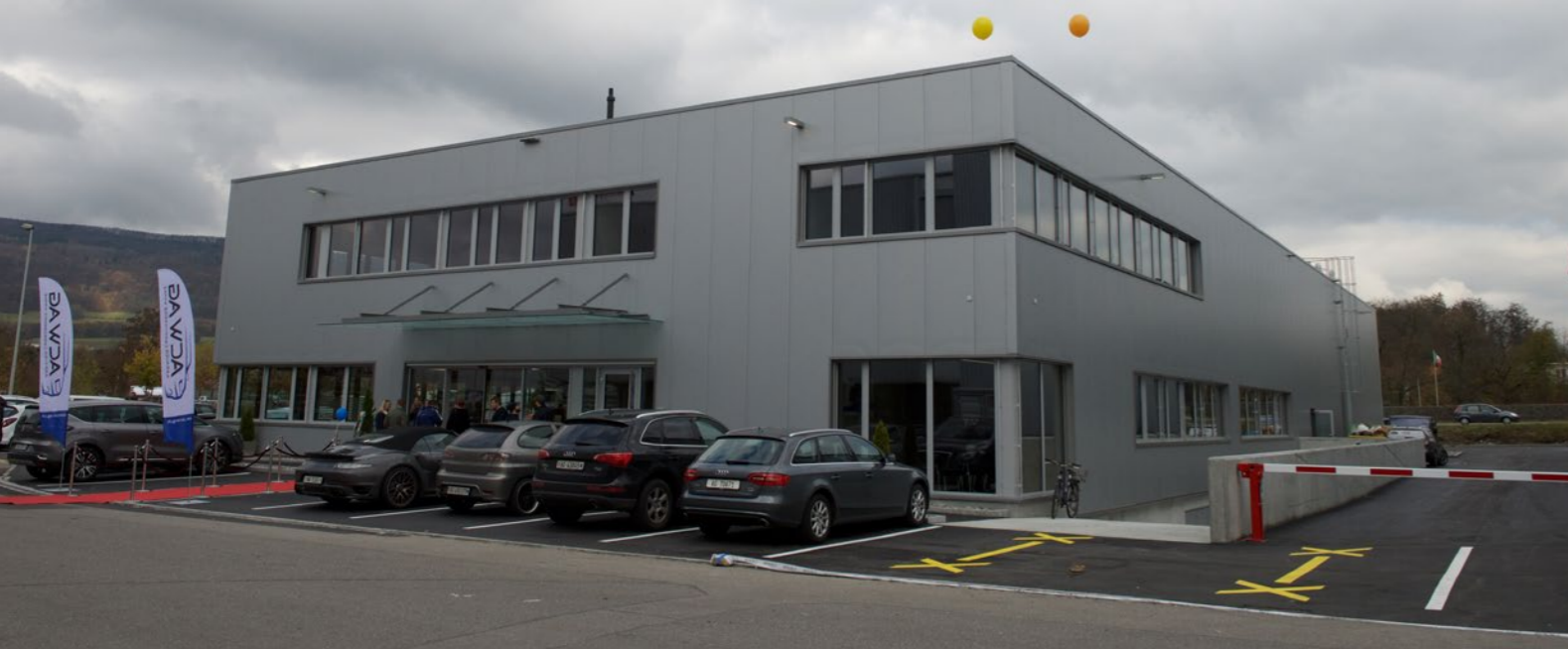
Nach rund zehn Monaten Bauzeit konnte das neue Gebäude bezogen werden.
